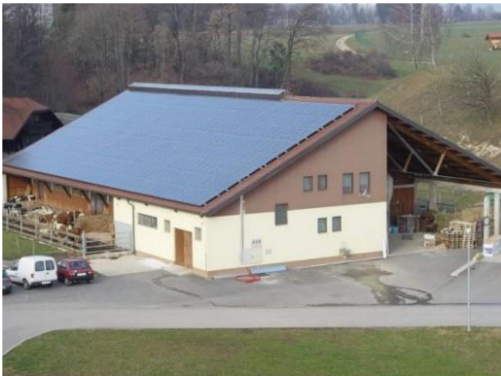
Slika 11-9: Sončna elektrarna na strehi objekta
